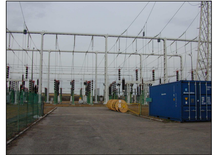
STAZIONE ELETTRICA DI SANDRÀ SOSTITUZIONE SEZIONATORI LINEE 205,228 W 210
