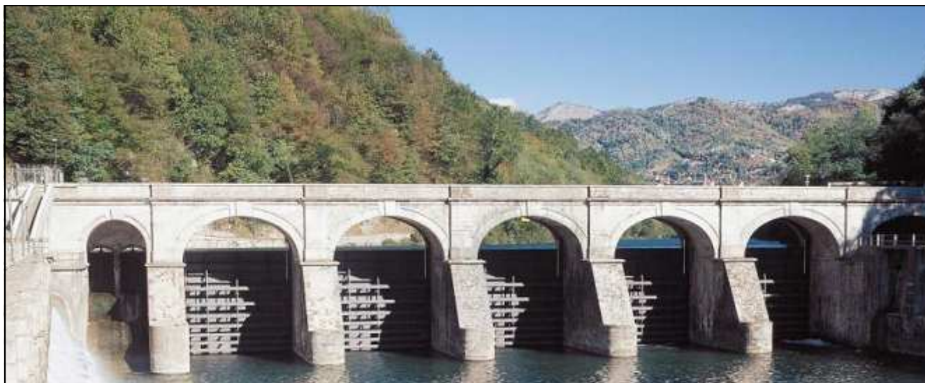
CENTRALE DI SEMENZA RIFACIMENTO IMPIANTO IDROELETTRICO
