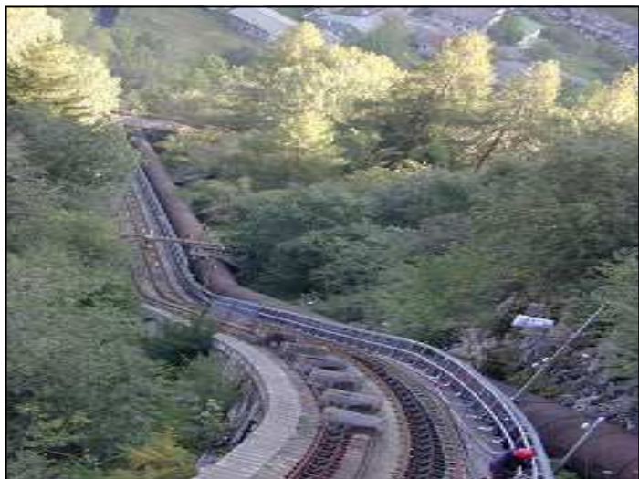
CENTRALE DI VEDELLO AMMODERNAMENTO DEL PIANO INCLINATO REDOCK
