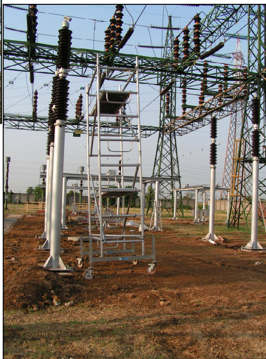
STAZIONE ELETTRICA DI CASSANO SOSTITUZIONE SEZIONATORI ED IMPLEMENTAZIONE S.I.S.T
