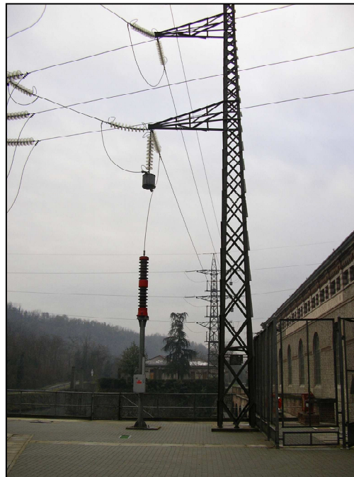
STAZIONE ELETTRICA DI BERTINI REALIZZAZIONE NUOVO MONTANTE LINEA No.026 132KW
