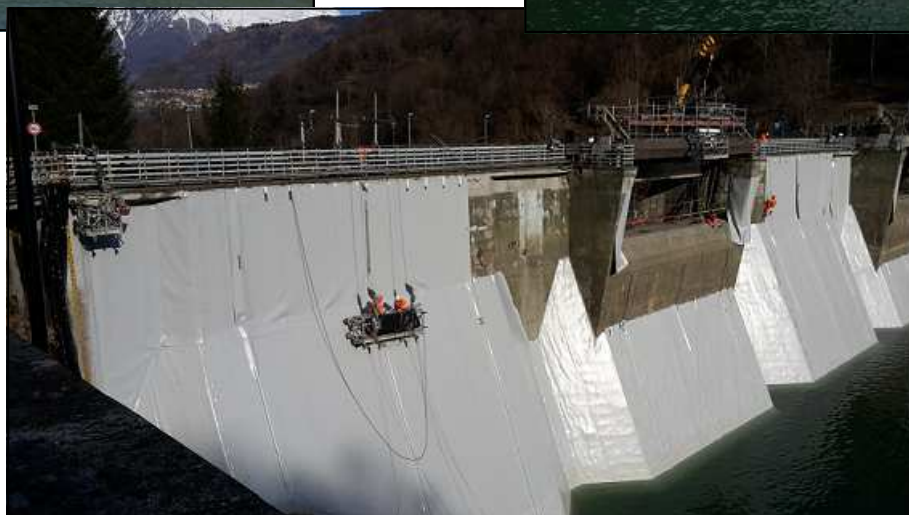
DIGA DEL POGGIA IMPERMEABILIZZAZIONE DEL PARAMENTO DI MONTE
