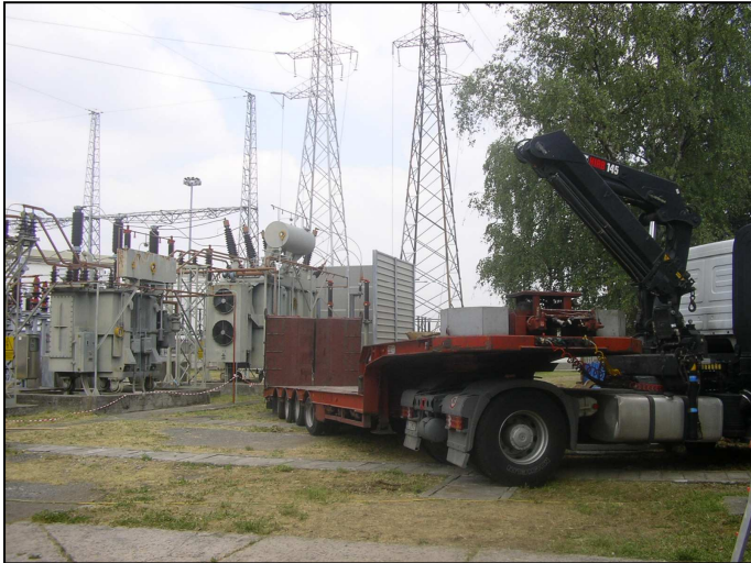
STAZIONE ELETTRICA DI ARCORE INSTALLAZIONE NUOVI SEZIONATORI
