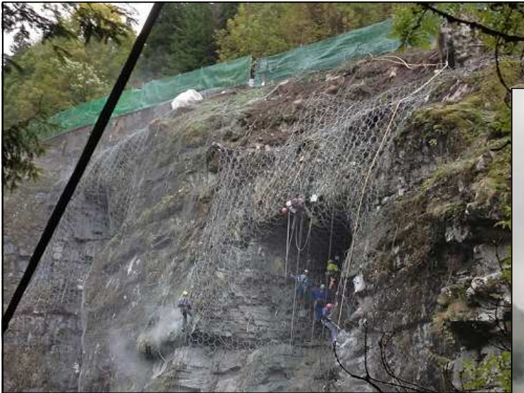
MESSA IN SICUREZZA PARETE ROCCIOSA SOPRASTANTE LA CENTRALE
