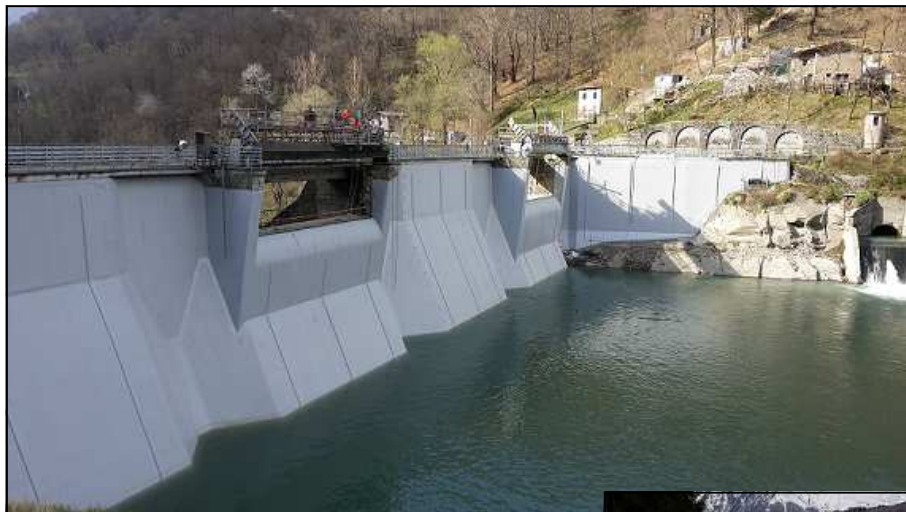
DIGA DEL POGGIA IMPERMEABILIZZAZIONE DEL PARAMENTO DI MONTE
